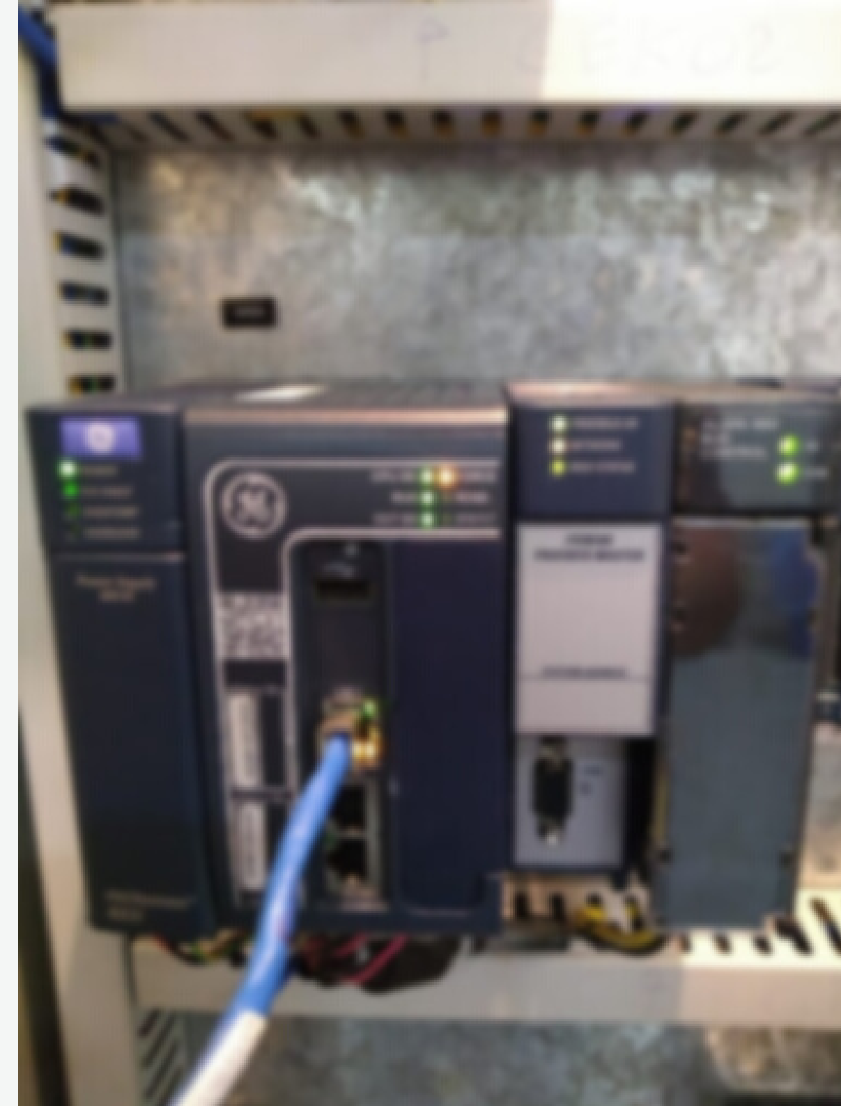
CLP - Controlador lógica programável da linha.
